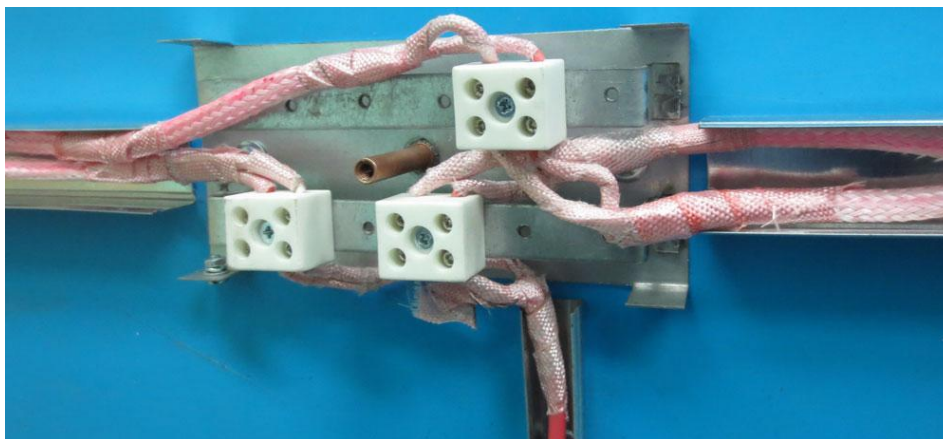
Рис. 26. Пример разделки и обработки кабеля в коробке КМ–О.
