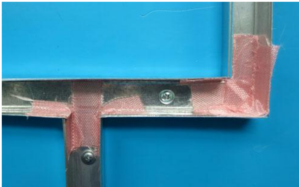
Рис. 19. Пример обработки резаных краев ККМО.
