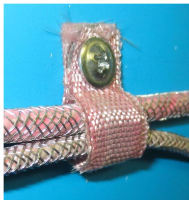
Рис. 5. Установка дюбель–хомута КФСТ.735322.041 и КФСТ.735322.164. Вариант 1.
