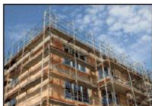
Монтаж строительных лесов
